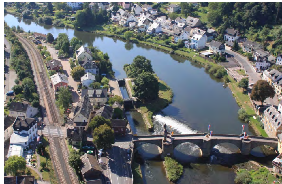
Luftbild Lahnschleuse Runkel
